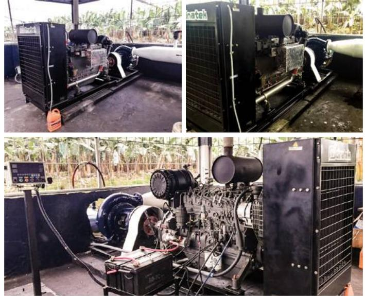
Con el propósito de suministrar la cantidad de agua necesaria, en el momento oportuno; en hacienda La Paz se realizó la instalación de un nuevo motor a diésel marca Weichai, modelo WP6-B144 de 6 cilindros, con una potencia continua de 193 HP y con un sistema de inyección directa con cámaras de alta presión.
